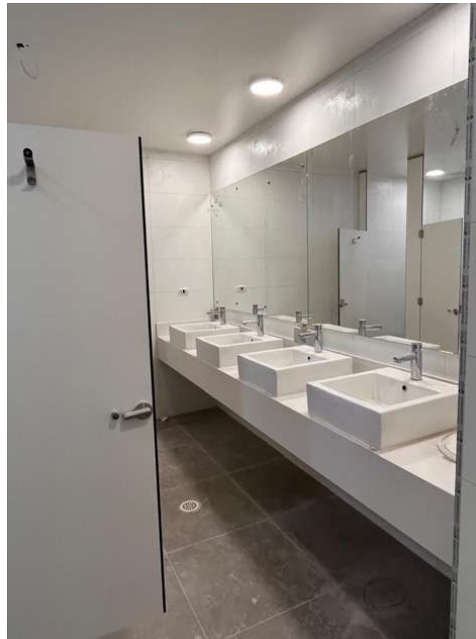
FOTOS PISO -1, actualmente en etapa de terminaciones
