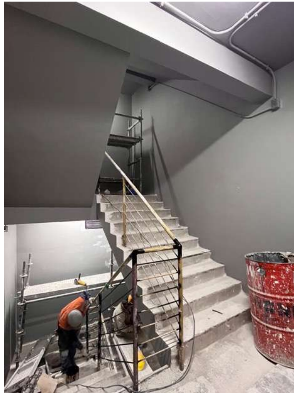
FOTOS PISO 2, actualmente en faenas de terminaciones
