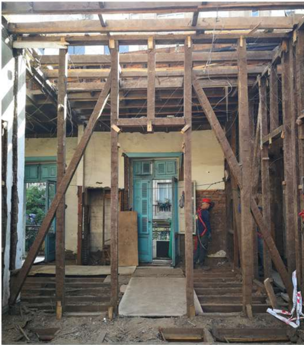
Proceso de demolición pisos 1 y 2
