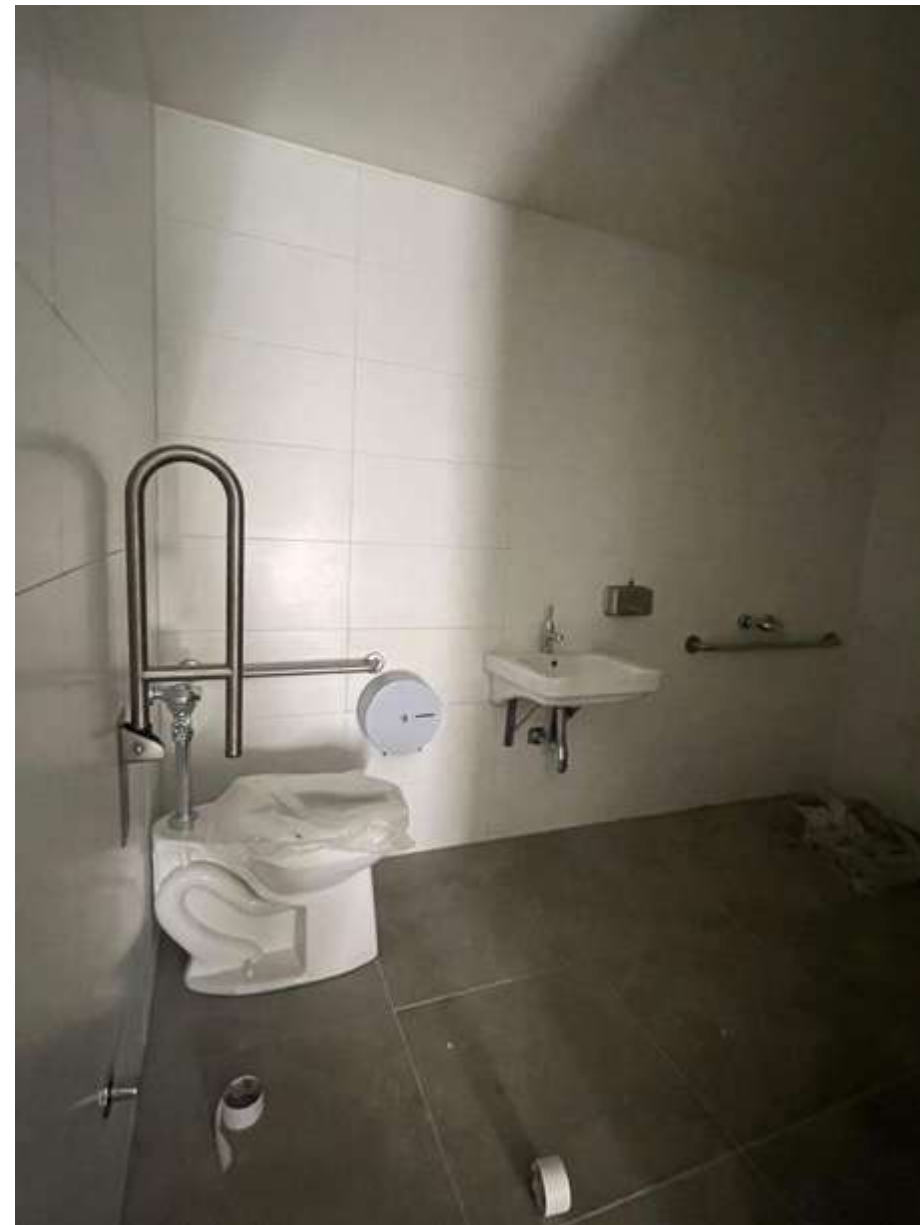
FOTOS PISO 3, actualmente en faenas de terminaciones
