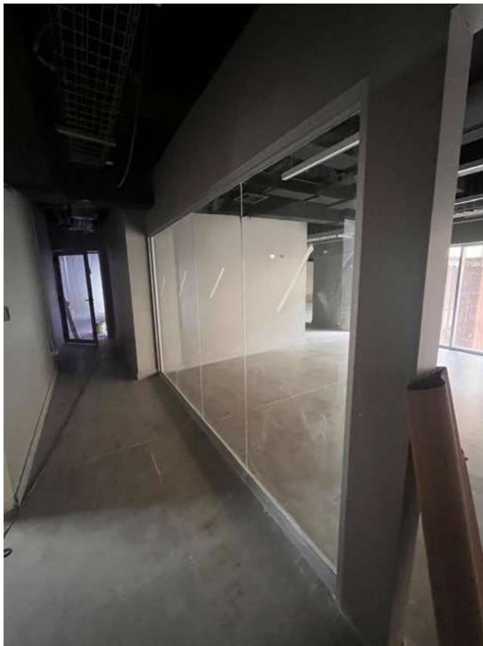
FOTOS PISO 3, actualmente en faenas de terminaciones
