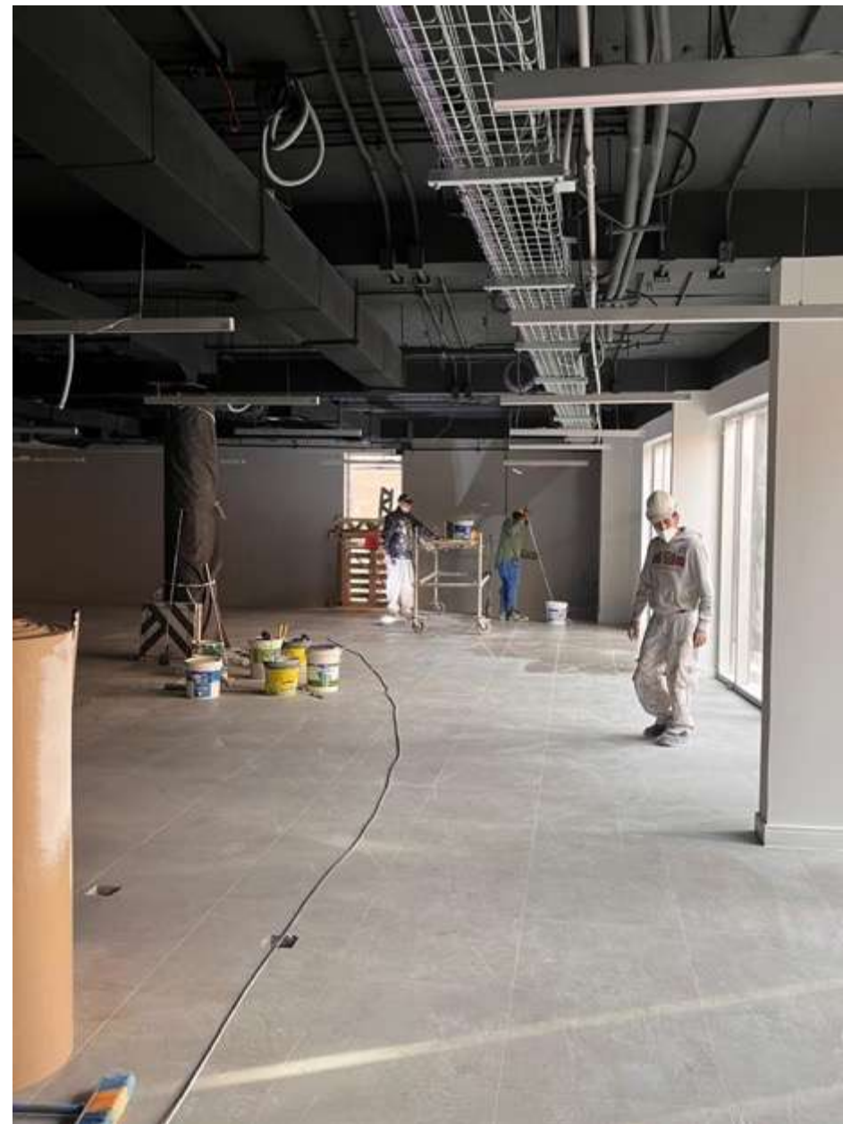
FOTOS PISO 2, actualmente en faenas de terminaciones
