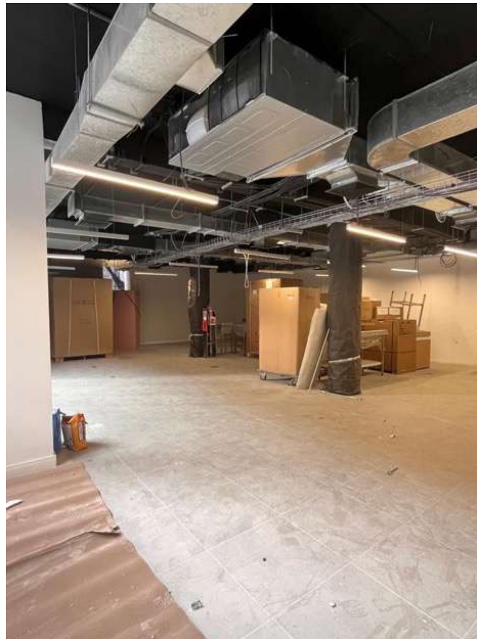
FOTOS PISO 1, actualmente en faenas de terminaciones.
