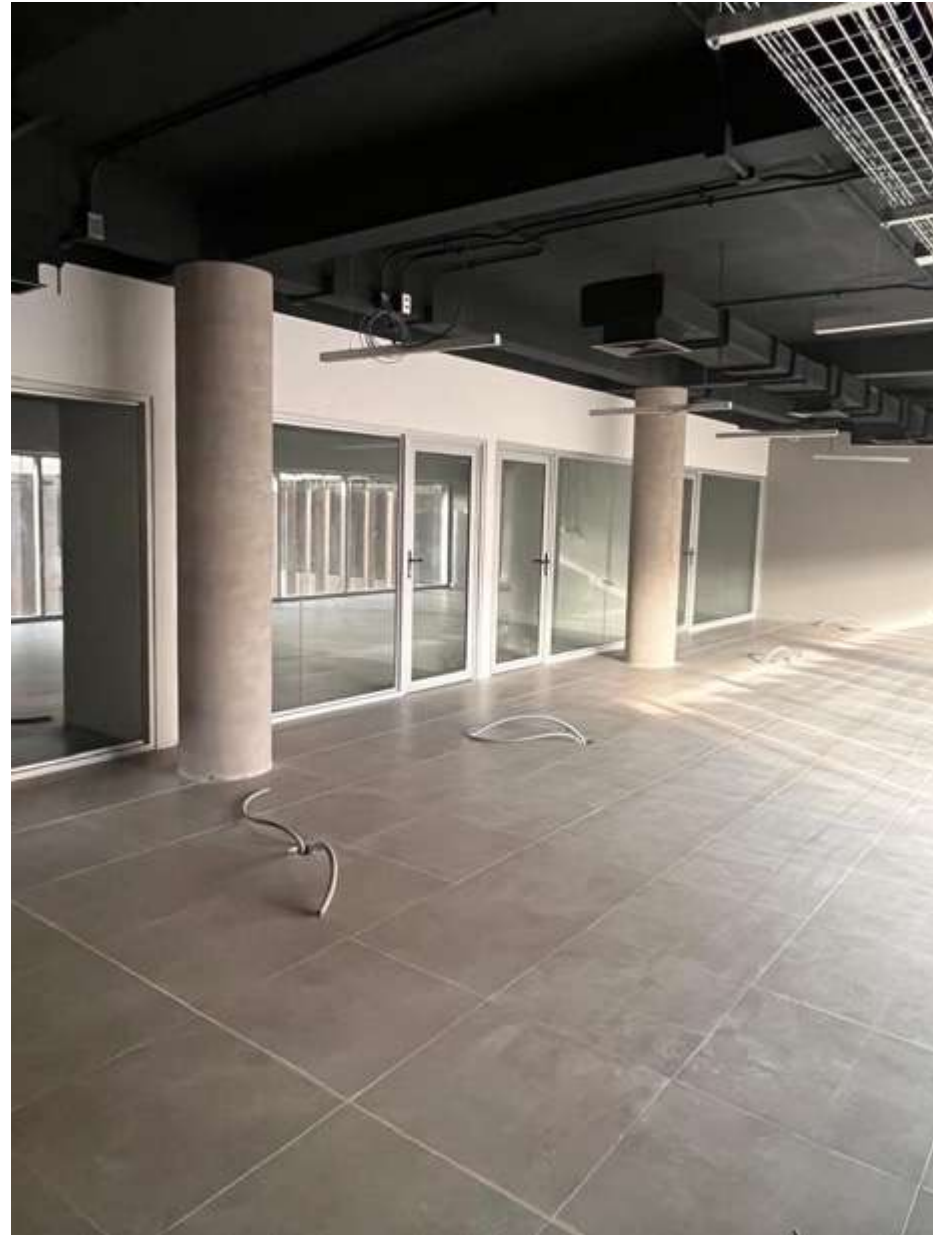
FOTOS PISO 3, actualmente en faenas de terminaciones
