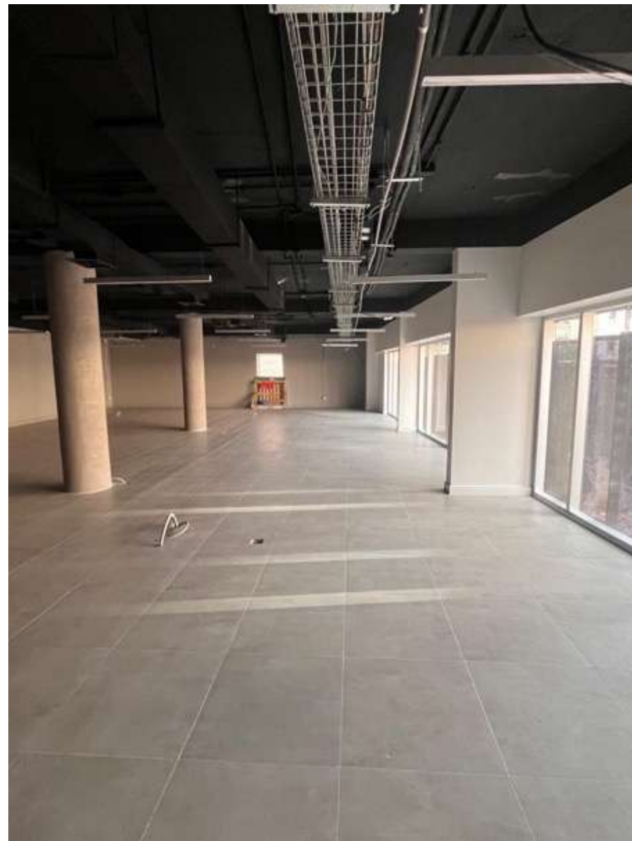
FOTOS PISO 3, actualmente en faenas de terminaciones
