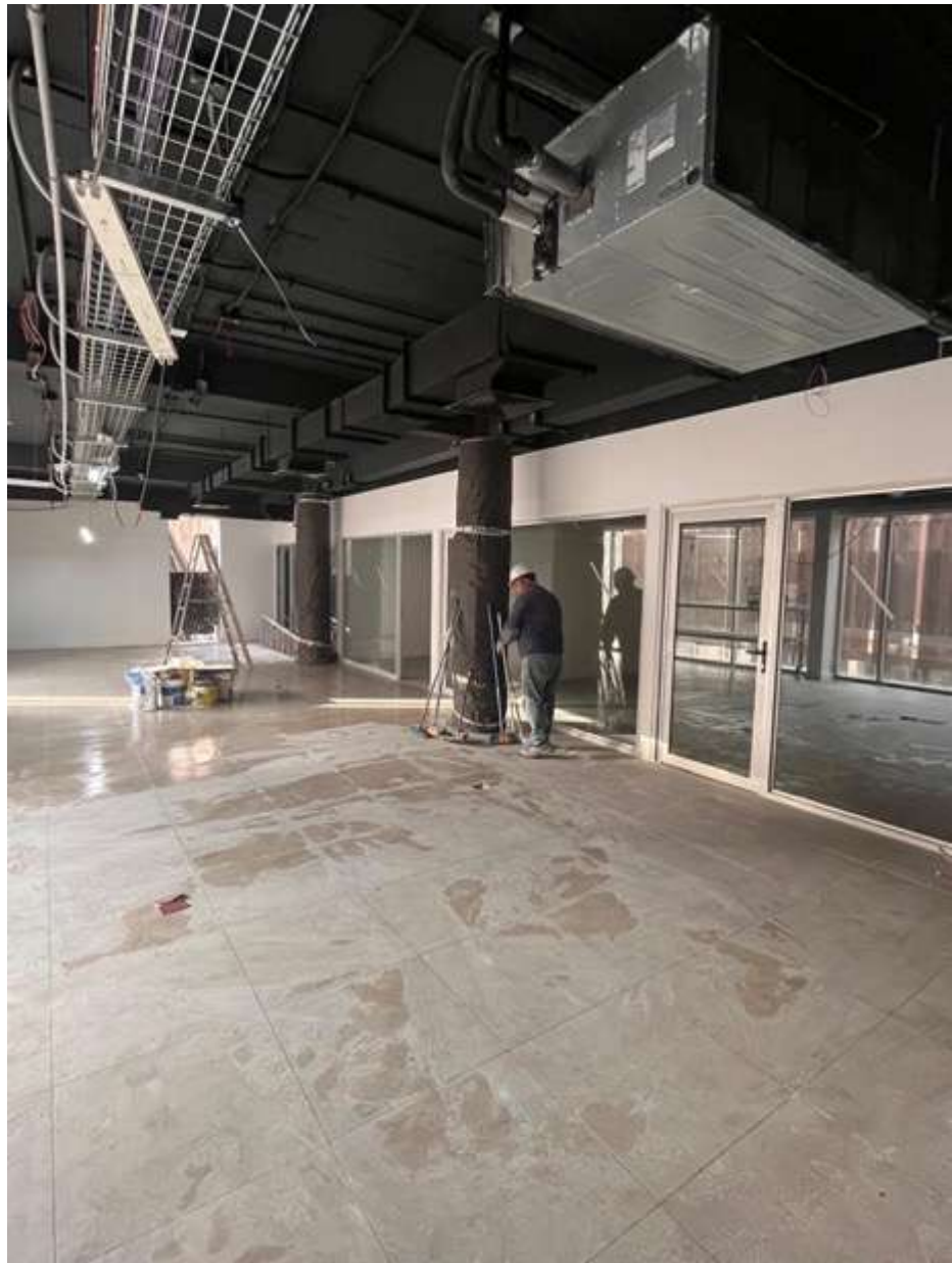
FOTOS PISO 2, actualmente en faenas de terminaciones
